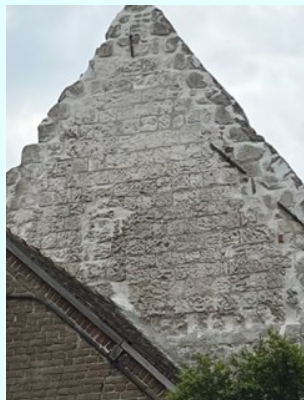
Réfection du pignon de l'église
