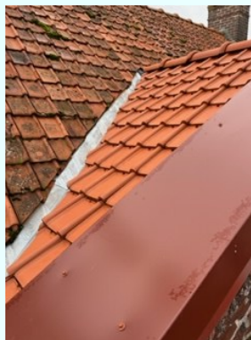
Réparation de la toiture de l'école
