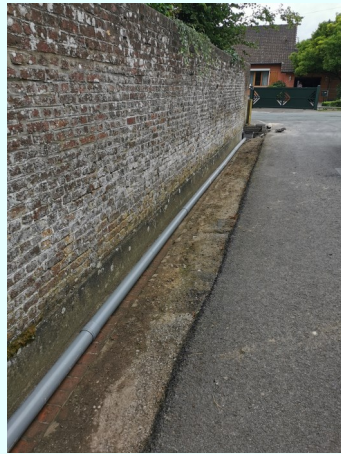
Busage d'un fossé rue Profonde permettant un élargissement de la rue
