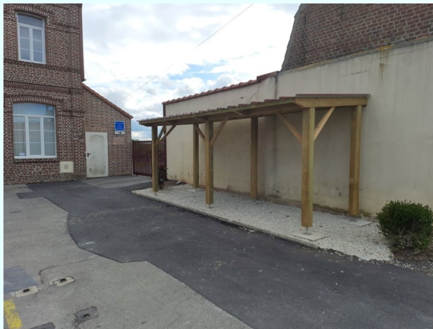
Réalisation d'un abri devant l'école
